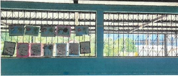
Foto 1: colocación de ventanas de PVC en modulo 1 y 2 ✓
