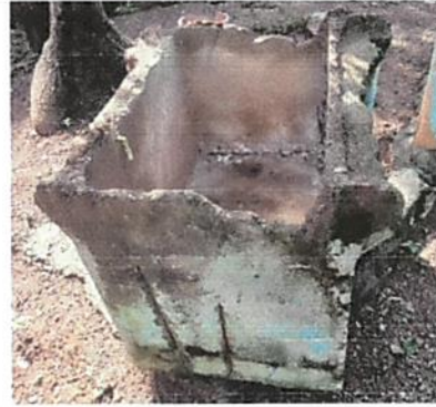
Foto 4: mejoramiento de instalaciones potables y pila nueva. ✓
